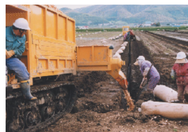
写真 1 チップ投入機による暗渠施工の様子
