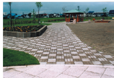
写真 4 木レンガを使った公園内散策路
