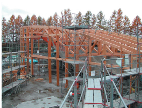
写真 6 カラマツ大断面集成材を用いた小学校の建設風景(帯広市)
