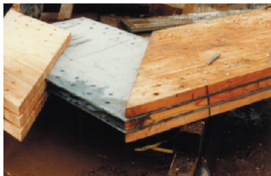
写真 2 鋼板挿入型ドリフトピン接合の施工
