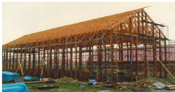
写真 7 PT型ハウスによる畜舎建築
