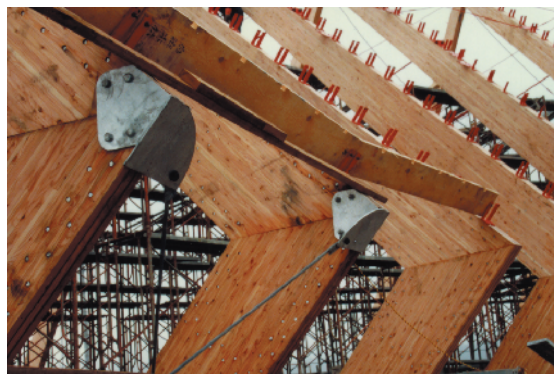
写真 1 カラマツ集成材のドリフトピンによる剛節接合
