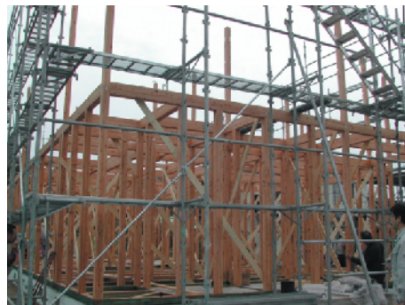
写真 7 カラマツ集成材を用いた住宅の建設風景(網走管内)
