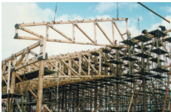
写真4 小屋組トラスの施工 (トラスはトドマツ、柱はカラマツ丸太)
